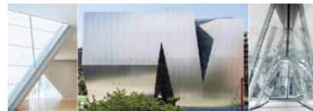
上左：バスの中で、いざ出発、上右：すみだ北斎美術館の前にて、下：外観とエントランス（設計は妹島和世氏）
